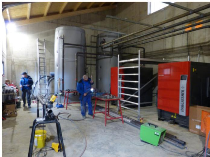
Bild: Die Verrohrung der Kessel und Pufferbehälter ist im Gange
