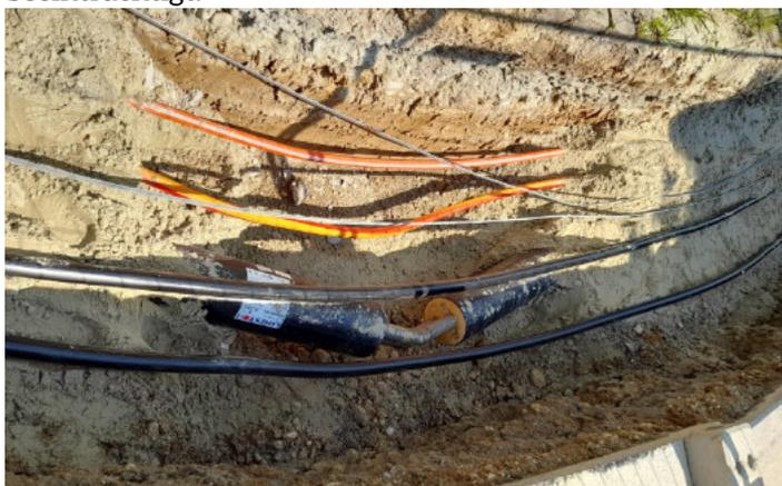
Bild: Häufig scheiterte die Fertigstellung an fehlender Isolierung.
