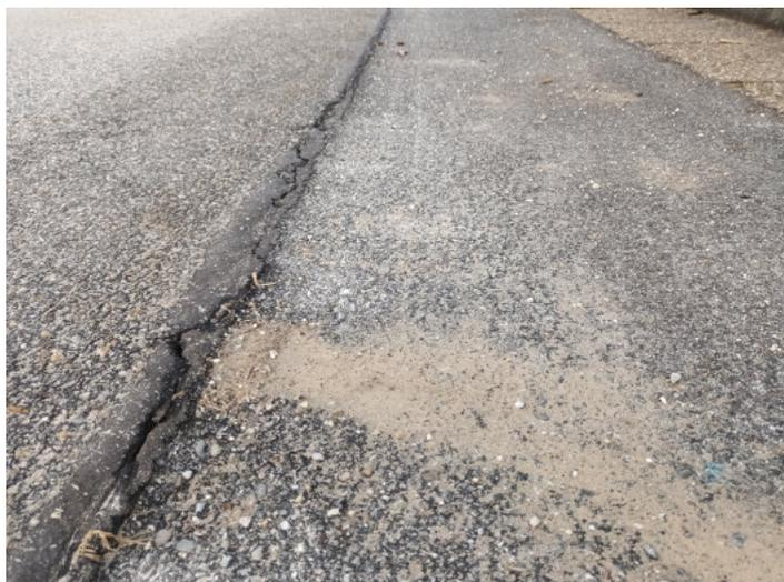
Bild: Risse in der Bitumenfuge als Folge von Setzungen der Asphaltdecke. Eindringendes Wasser führt zu Frostschäden.
